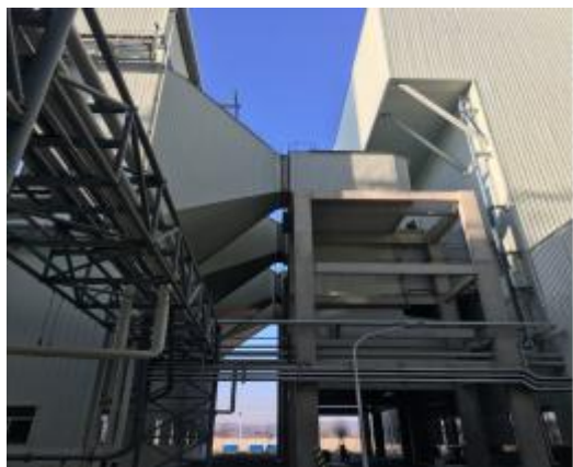
双室五电场静电除尘器及湿式电除尘器
