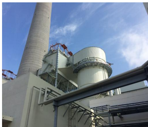
双室五电场静电除尘器及湿式电除尘器
